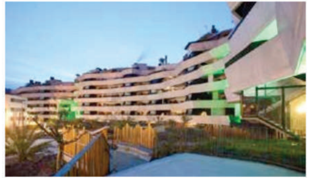
Konut Kompleksi (çatı bahçeleri)
